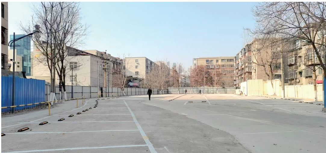
新修建好的停车场
