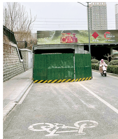
围挡长期存在影响正常通行
