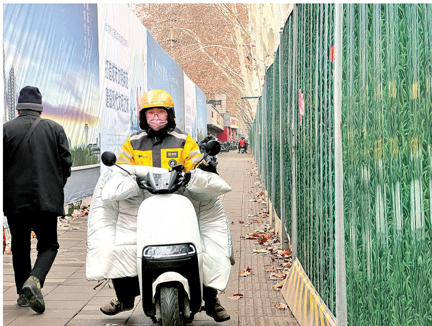
桃源路东段围挡还未拆除
