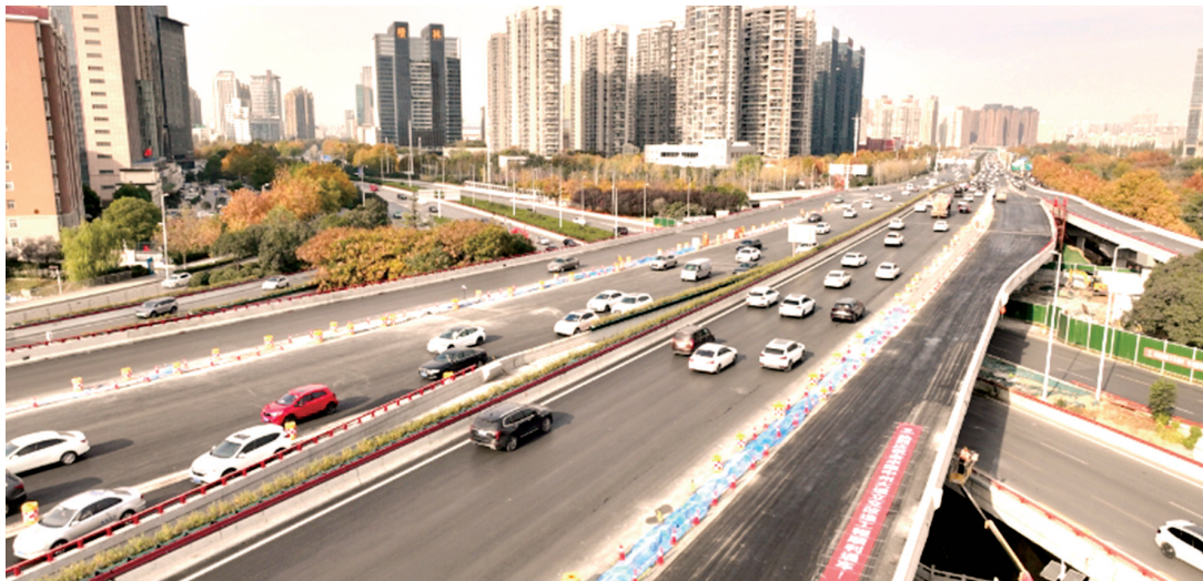
中州大道立交及地面道路主线全部改造完成通车
