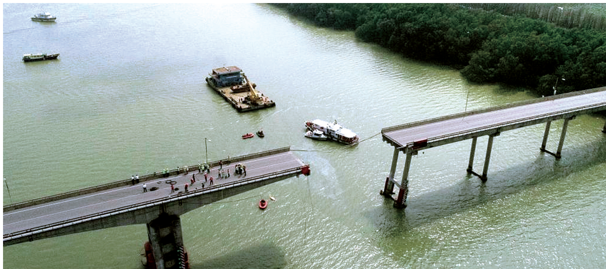
2月22日,救援人员在沥心沙大桥事故现场进行救援 新华社发
