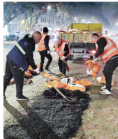
夜间修补路面
