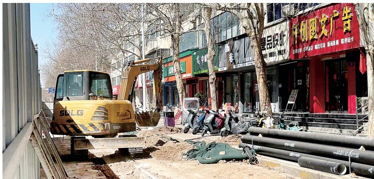
老旧管网改造加紧收尾
