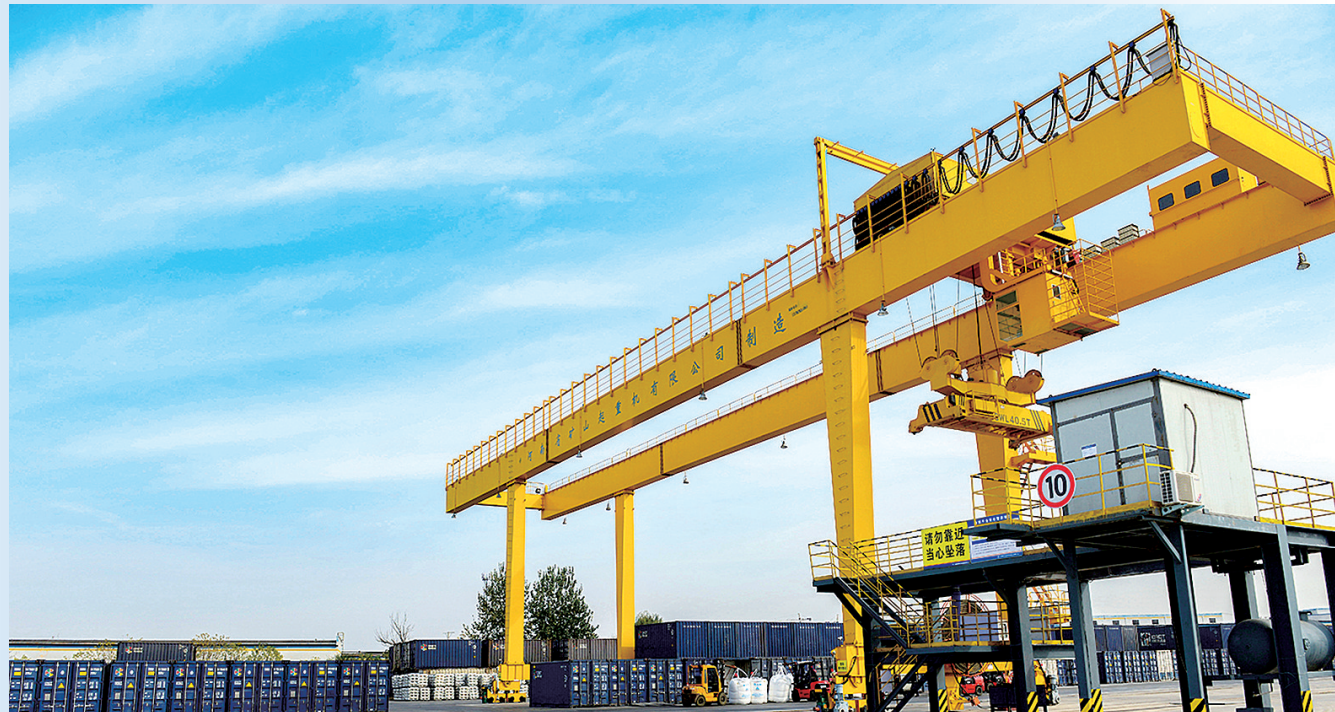
国际陆港枢纽龙门起重机
