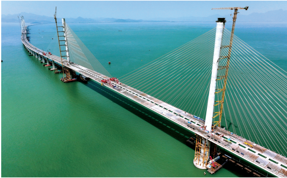
黄茅海跨海通道高栏港大桥 新华社发
