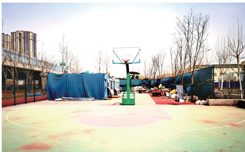
运动场内搭建有简易房,堆放着建材等物品
