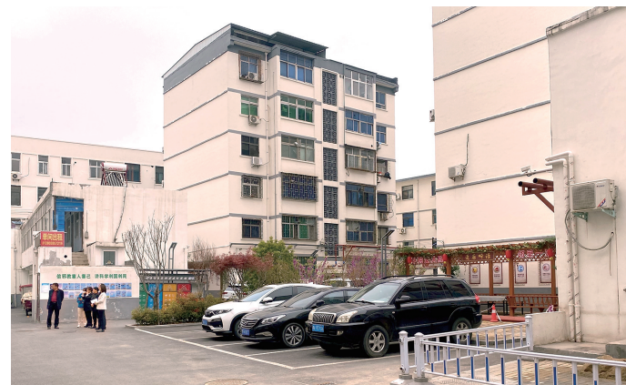
院内路面重新铺设，增加机动车停车位
