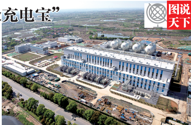
湖北应城300兆瓦级压缩空气储能电站 新华社发
