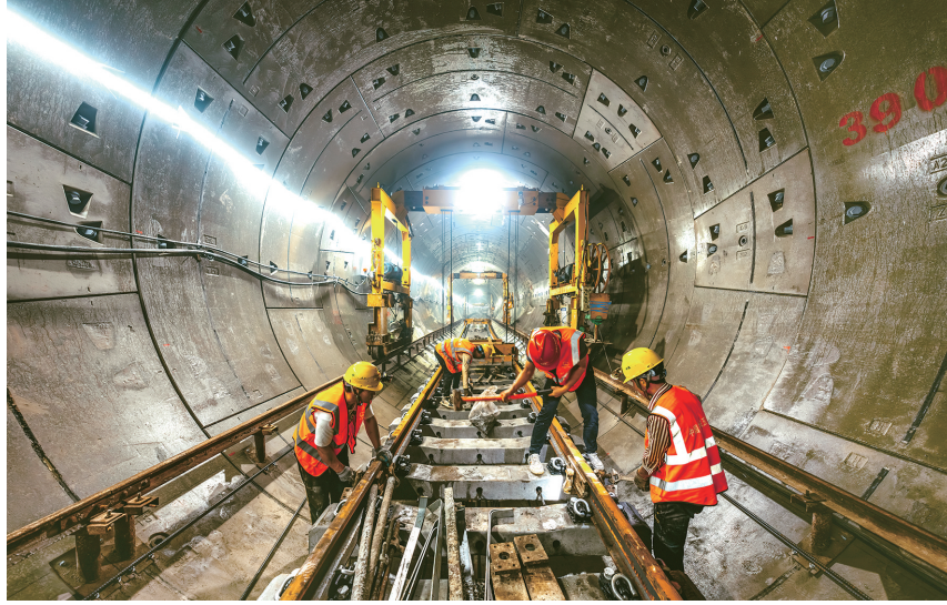
图为施工现场
