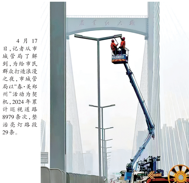
市政工人检修路灯
