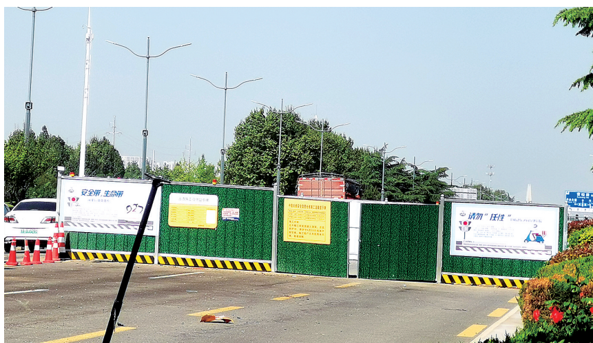
中原大桥部分路段仍在围挡施工
