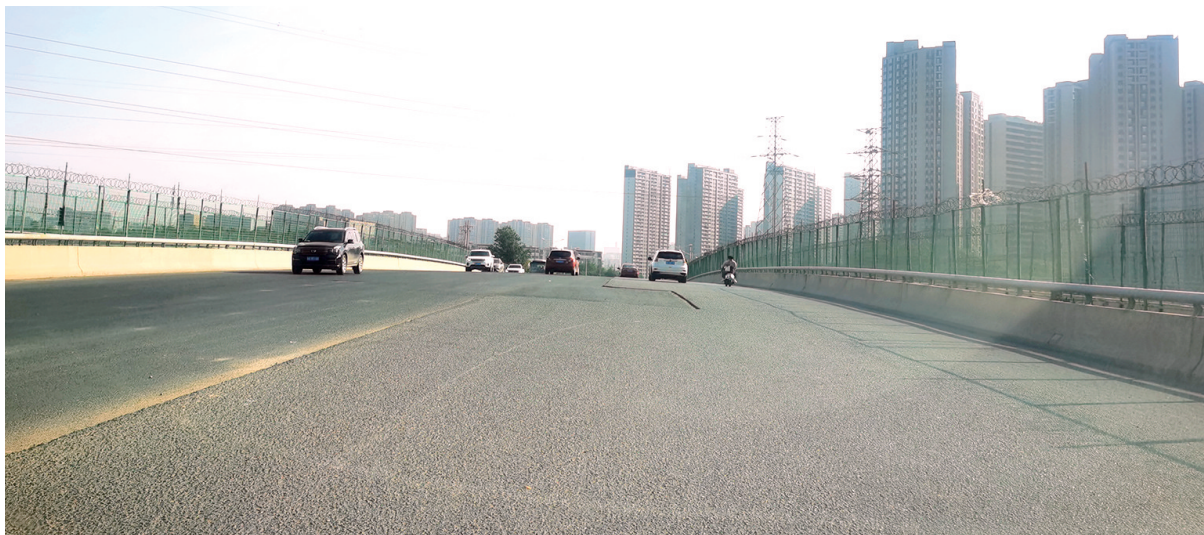
平坦的长江路南水北调大桥桥面
