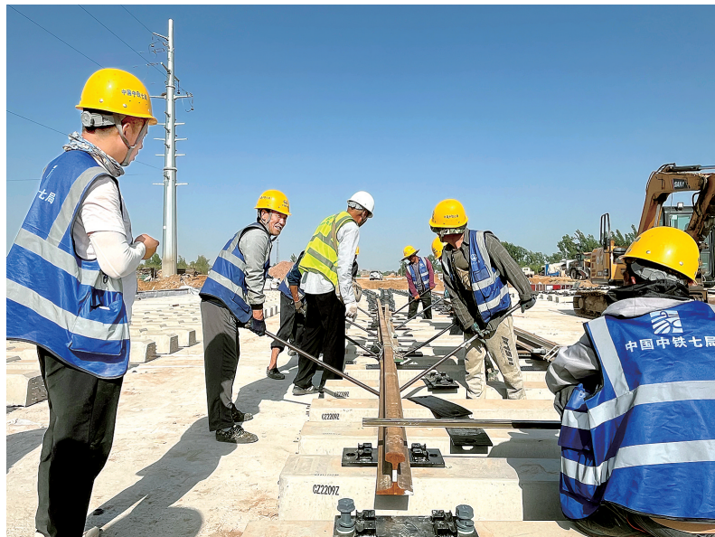
工人抓紧施工
