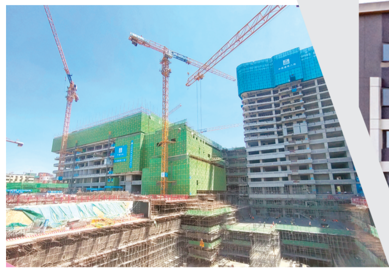
郑州大学第一附属医院惠济院区改扩建项目施工现场
