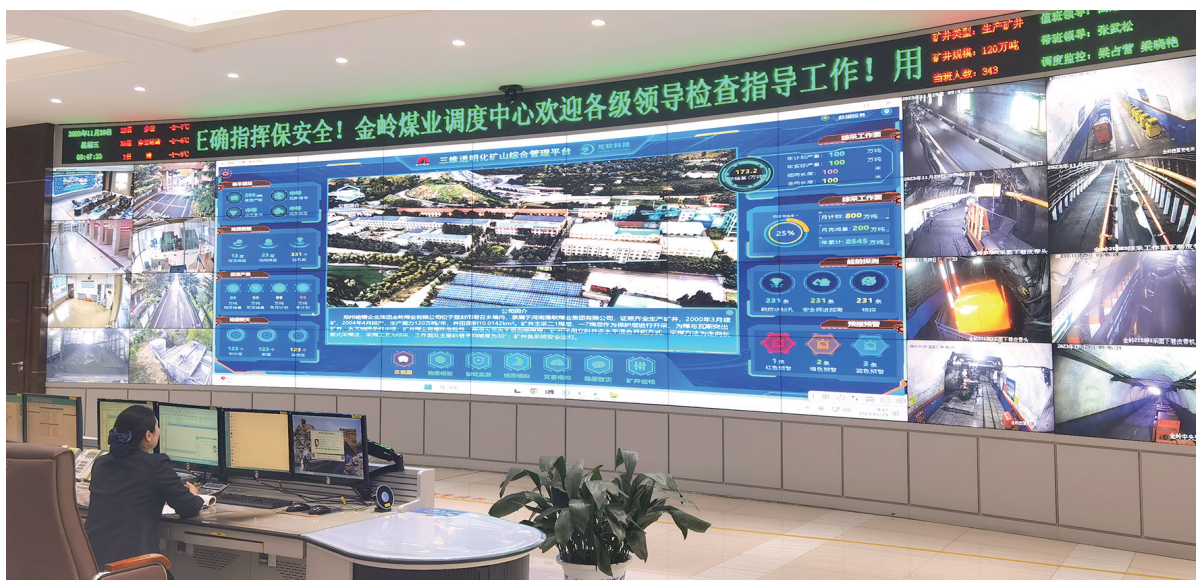
金岭煤矿调度中心
