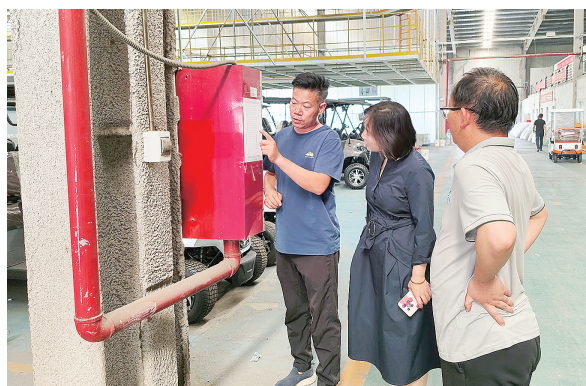
网格员排查消防安全隐患
