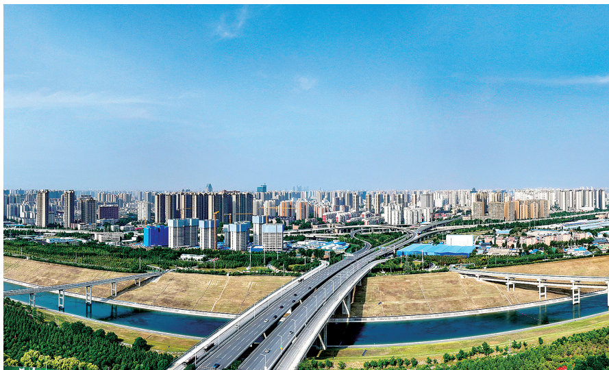
位于中原区航海路的南水北调渠桥
