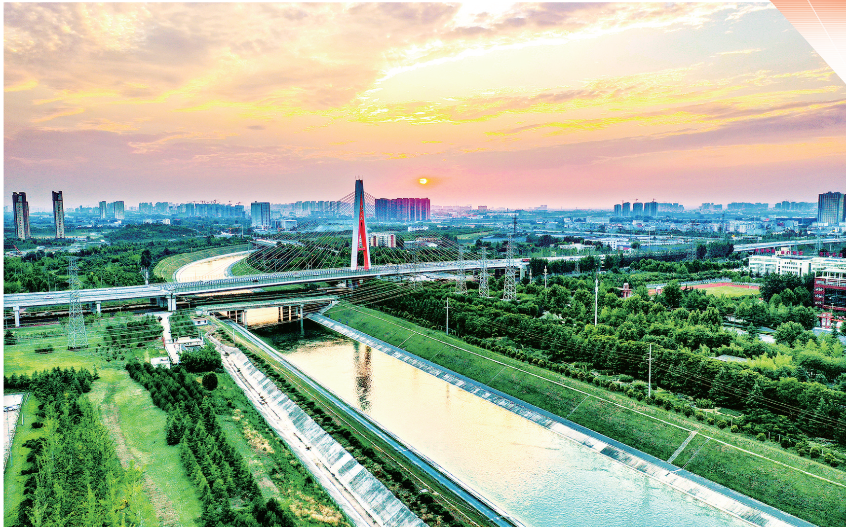
南水北调总干渠奥体大桥
