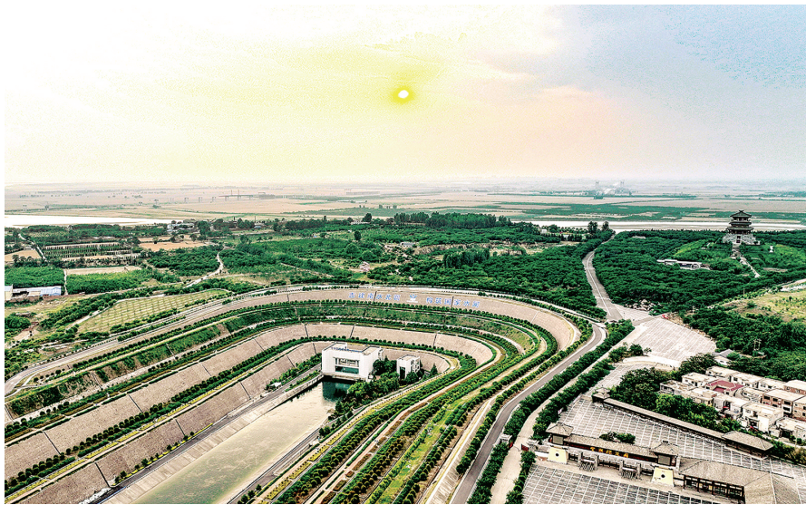
南水北调中线穿黄工程位于荥阳境内
