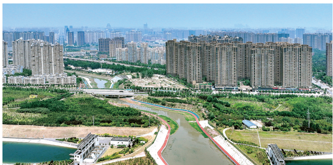
位于二七区的金水河跨过南水北调渠
