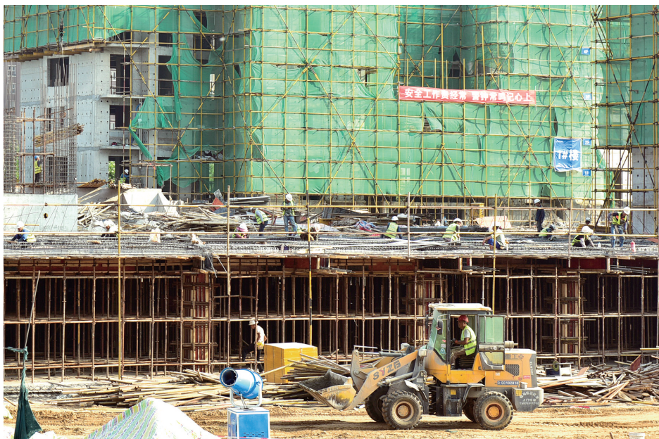
绿都青云叙四期上璟苑项目施工热火朝天
