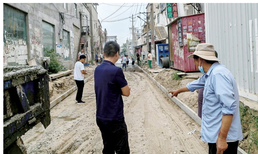
道路正在施工修建
