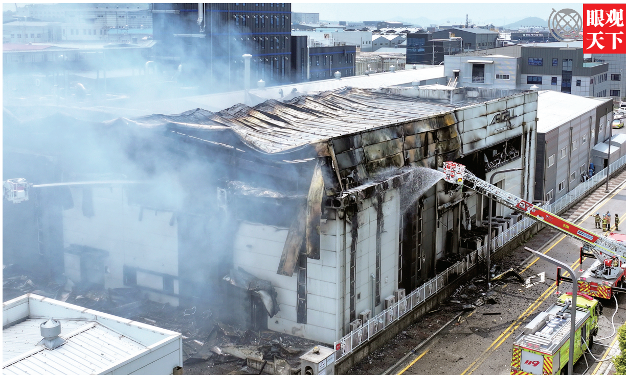
消防员在韩国京畿道华城市的电池工厂火灾现场灭火 新华社发
