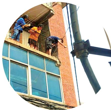
场,来到该户阳台,对外墙检查后,对存在着安全隐患的部分墙面进行铲除,消除再次发生脱落带来的危险。
