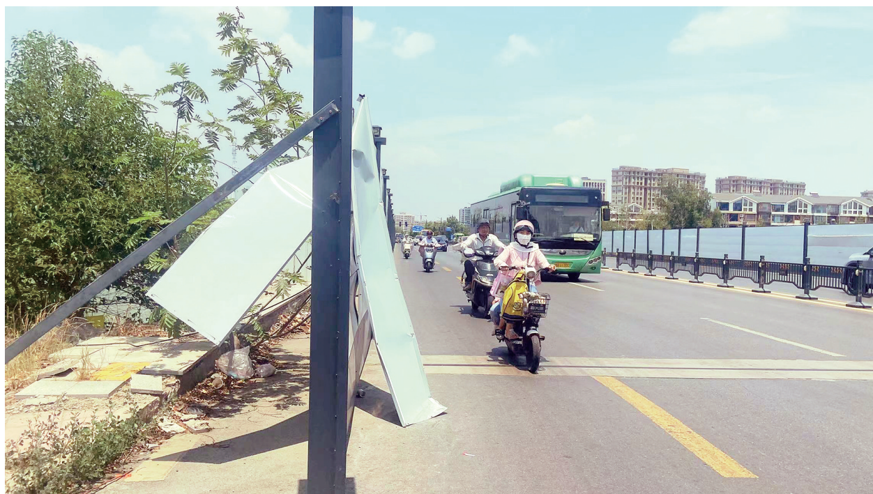
临时护栏占道且破损
