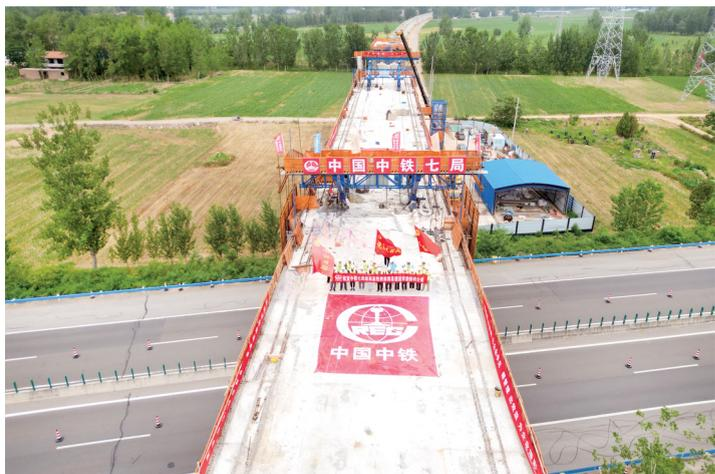
本报讯(记者 张倩 通讯员 张兆华 王智迪 文/图)6月29日凌晨,在雄商高铁商丘段建设现场,随着最后一方混凝土浇筑完成,由中铁七局集团承建的雄商高铁跨商周高速公路连续梁顺利完成合龙施工,又成功打通了一处箱梁铺架“卡脖子”节点。这标志着项
