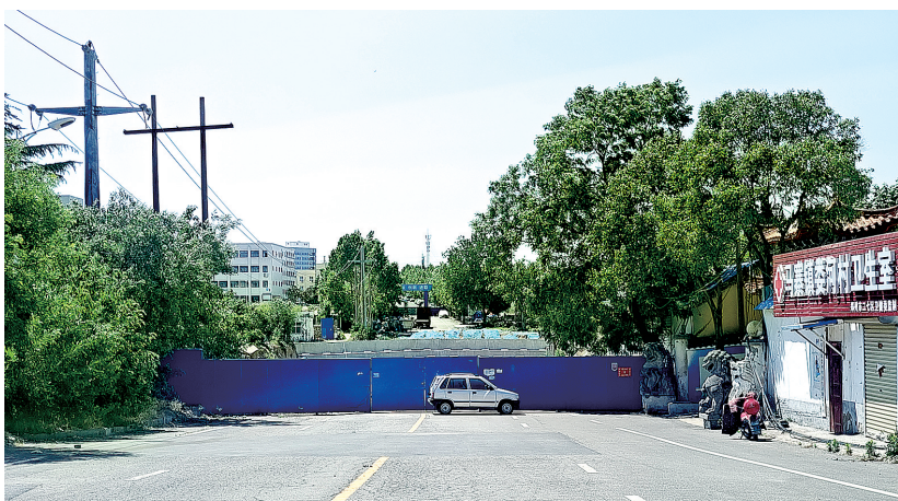
改建中的孔河桥工地中断了道路
