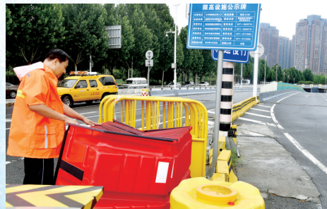
红专路下穿中州大道隧道口,检查挡水板
