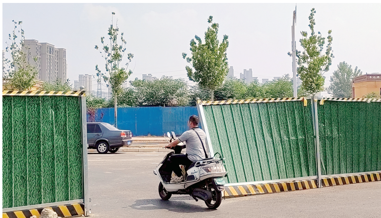
腾飞路路面施工已完成,但围挡还未拆除
