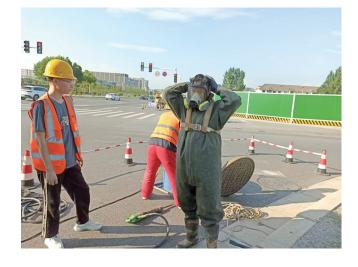
堆砌"一般,将内径800 毫米的雨水管道完全堵 塞,雨水排放只能从缝 隙中穿流。还有翱翔路 与洪泽湖路处,雨水、淤 泥和石块混合形成了一 道天然屏障,致使雨水 无法及时排放。
