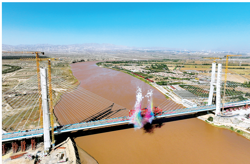
10月9日,包银高铁乌海黄河特大桥合龙贯通 新华社发
