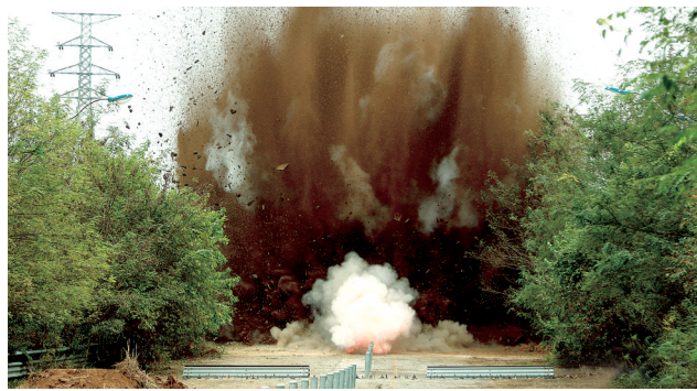
朝方以爆破方式封闭公路 新华社发
