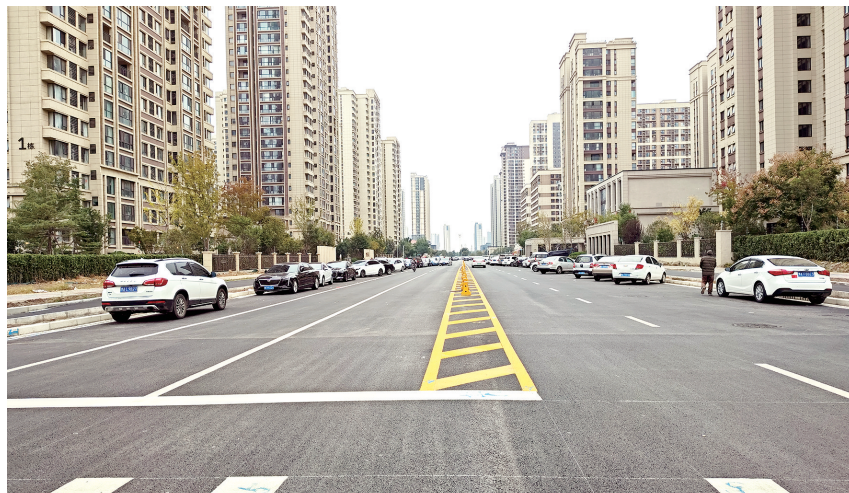
围挡已经拆除的站马屯路
