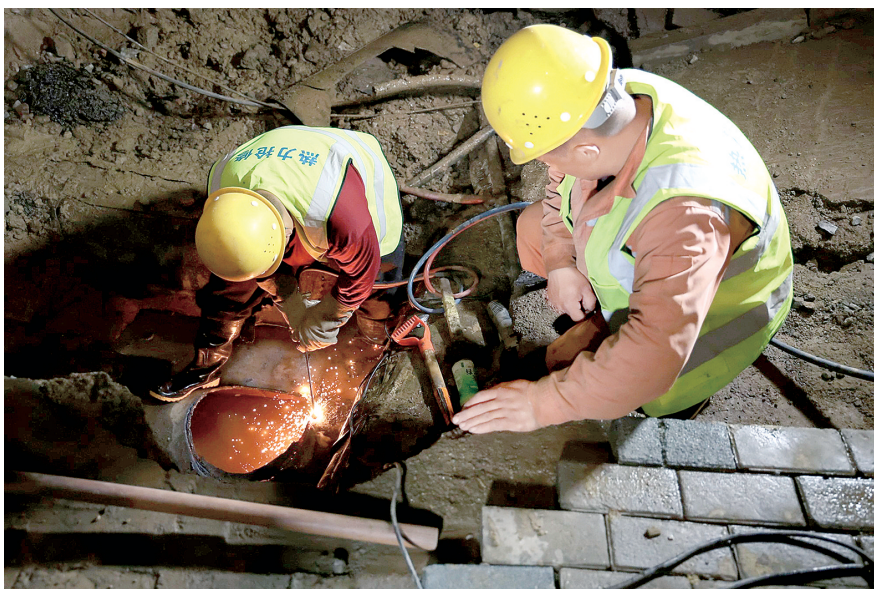
连夜修复爆裂管道
