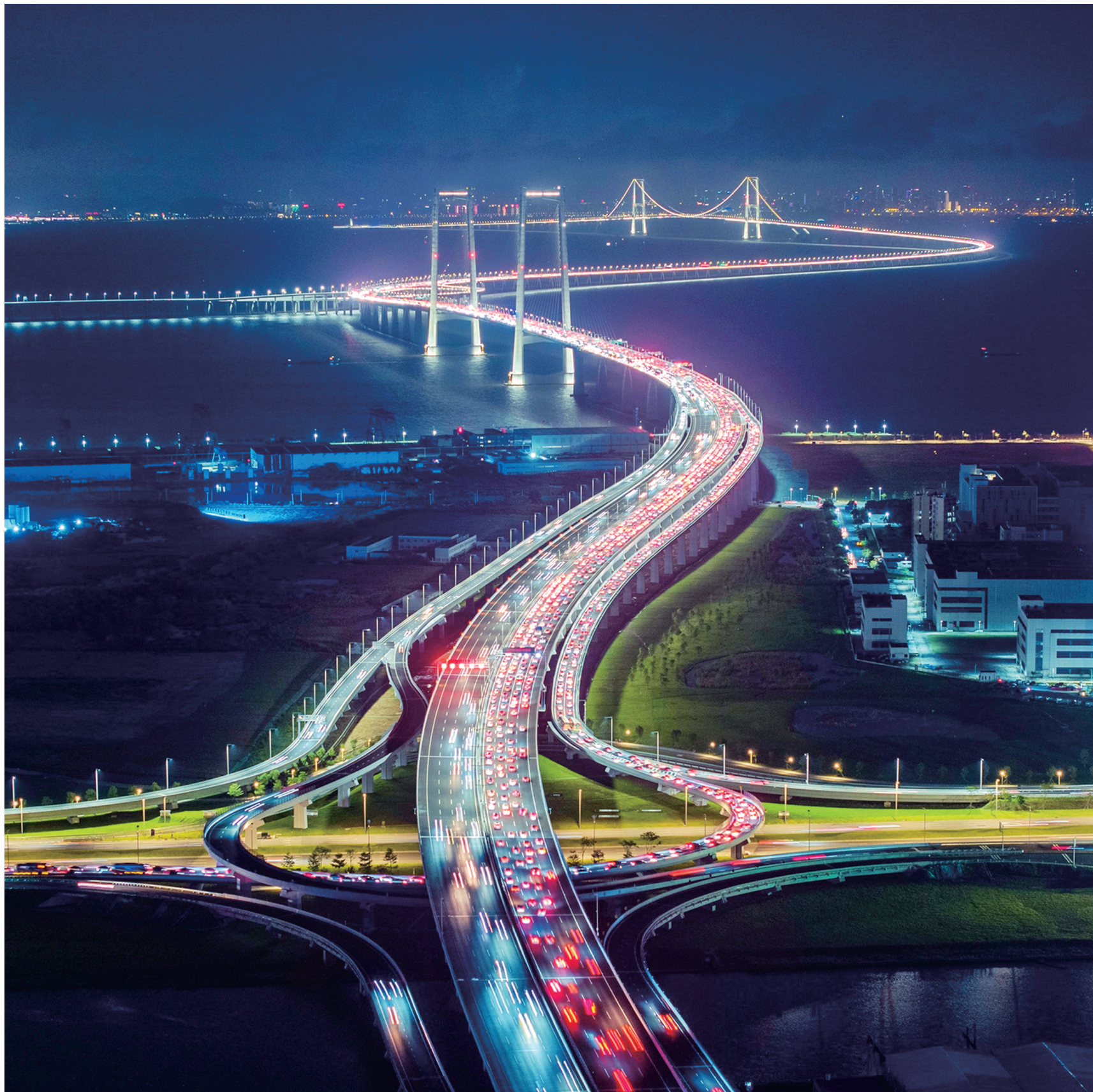
2024年6月30日,深中通道正式开通,深中两地紧密结合的日子到来了,市民争相登上这一世纪工程先睹为快。俯瞰桥上车流如龙。黄欣仪 摄
