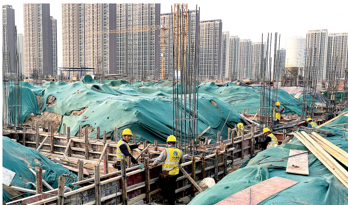
娃哈哈精制饮料工厂项目施工现场
