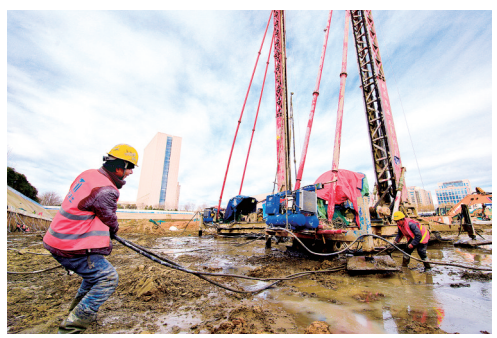
工人在弘坊项目有序忙碌着
