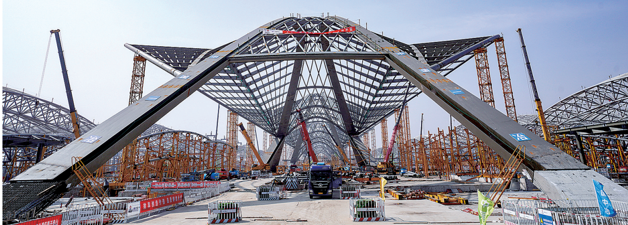
中原国际会展中心二期“龙脊”施工现场
