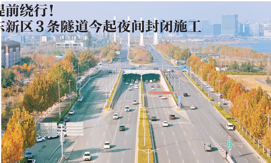
北三环东延下穿隧道
