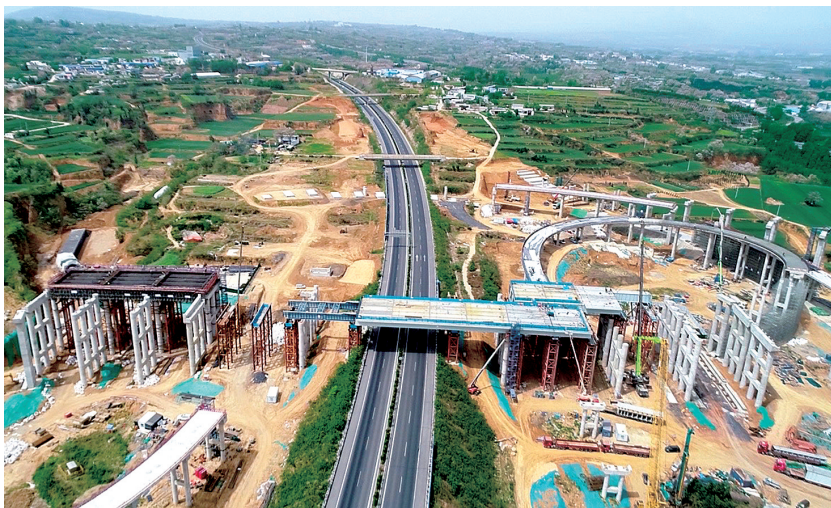
大崔沟枢纽互通式立交施工现场
