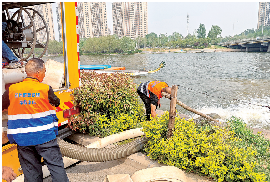
防汛演练现场
