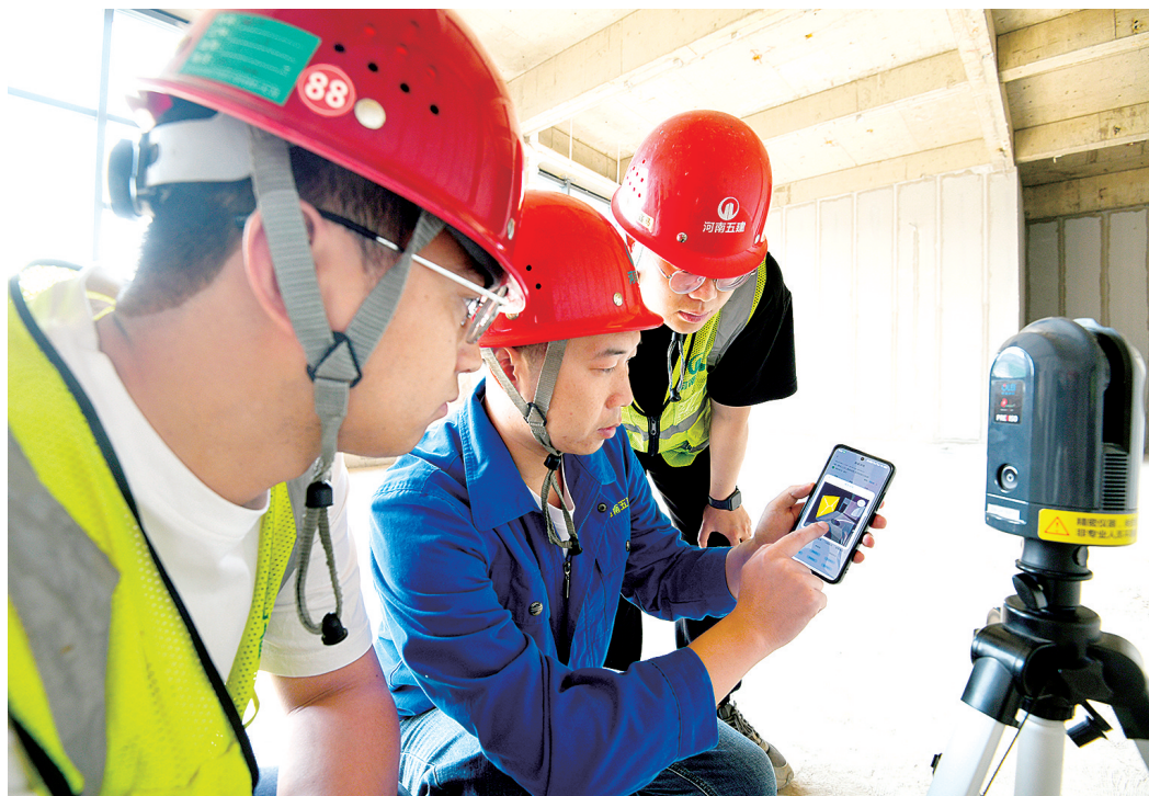
施工人员正操作点云三维激光扫描仪为房屋进行建模
