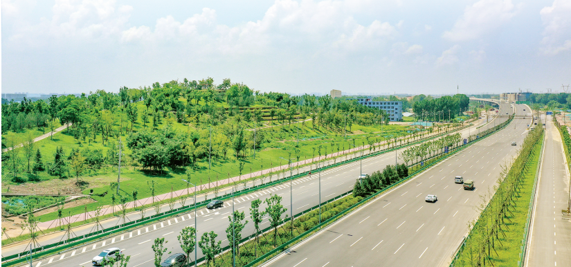
沿黄大堤复合生态廊道已建成
