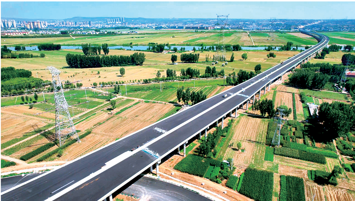
建设中的沁伊(沁阳—伊川)高速巩义段
