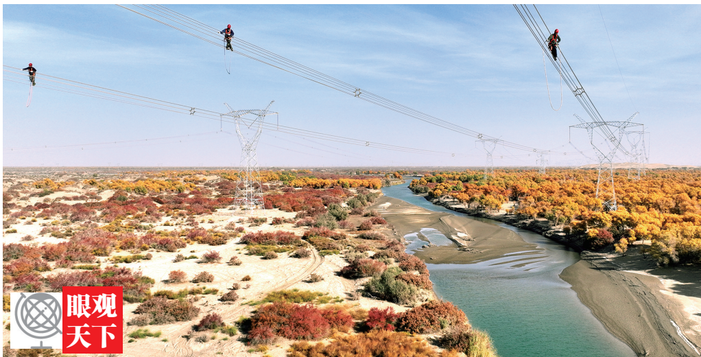
作业人员开展走线消缺作业(无人机照片) 新华社发
