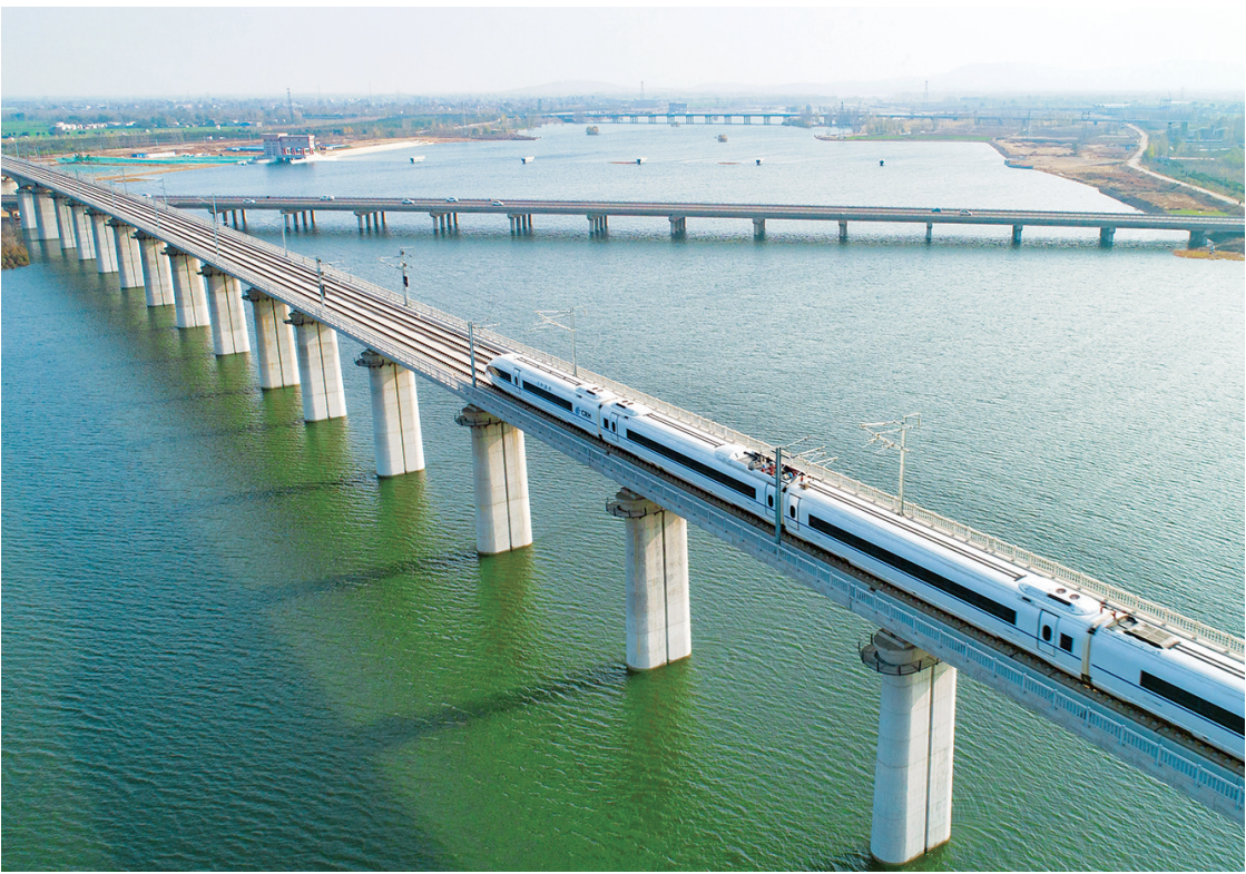
—列高铁从郑渝铁路郏县北汝河大桥驶过
