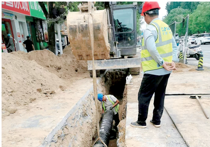
老旧供水管网施工现场
