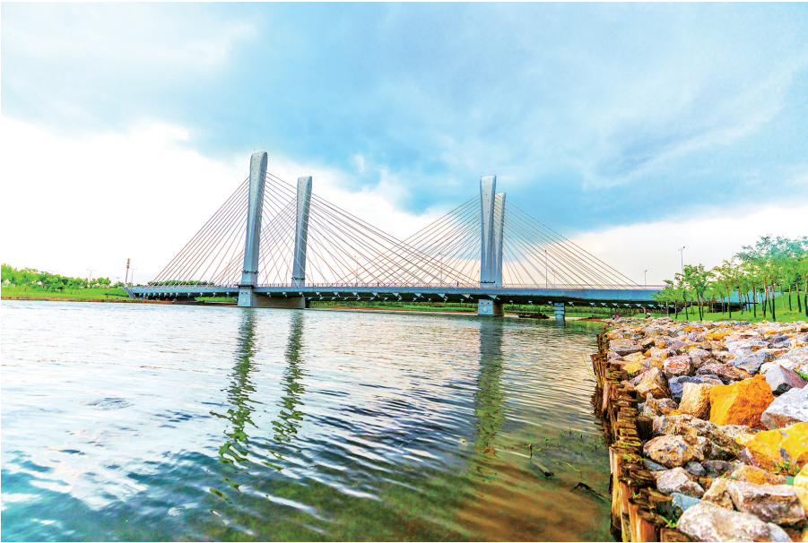
桥梁安装高清视频监控设备
