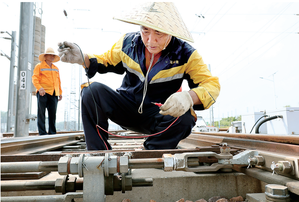
工作人员在进行道岔检修作业
